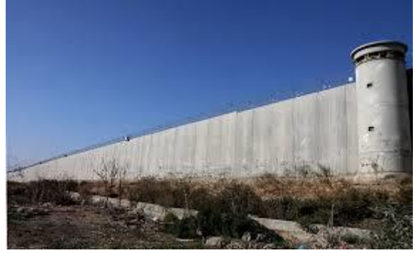
برج مراقبة جزء من بناء الجدار(4)
